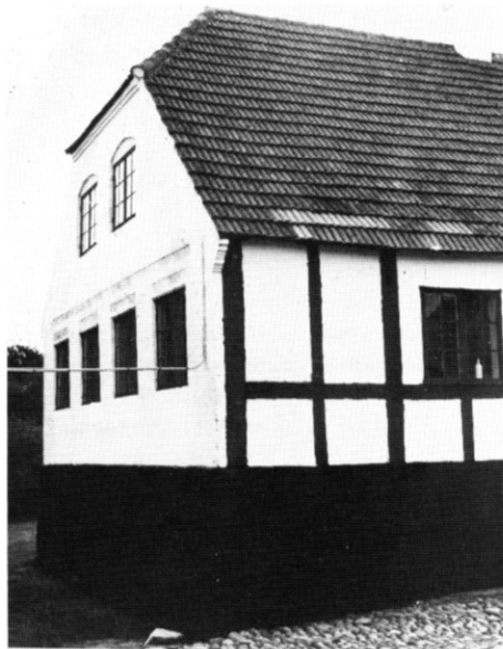
Fig. 58. Muret gavl med mønstermurværk. Møllegård, 3. slg. Rø. Foto: BM, 1976.
