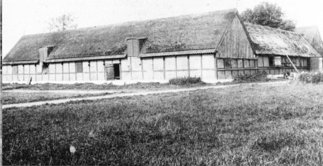
Fig. 60. Hjortegård, 1. vgd. i Pedersker, søndre længe fra 1844. Midt i længen tre stolper med dobbelte bjælker, hvor der oprindeligt var kostald. Bemærk desuden vandbrædderne på gavl og østre længe til beskyttelse af undertavl. Kvistene er en senere tilføjelse, sikkert fra århundredskiftet. Tagstenene i tagfæsten er uden tvivl fra samme tidspunkt. Ældre foto.
