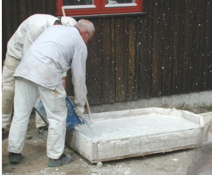
Læskning til træforet jordkule, i Den gamle by i Aarhus. Vandet fra kalkvællingen siver ud i jorden, og der dannes den tykke kalkdej, som helst skal lagre i mindst 2 år.
