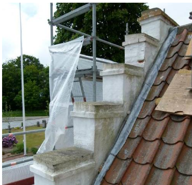
De intakte cementafdækninger blev bevaret og revner repareret.
