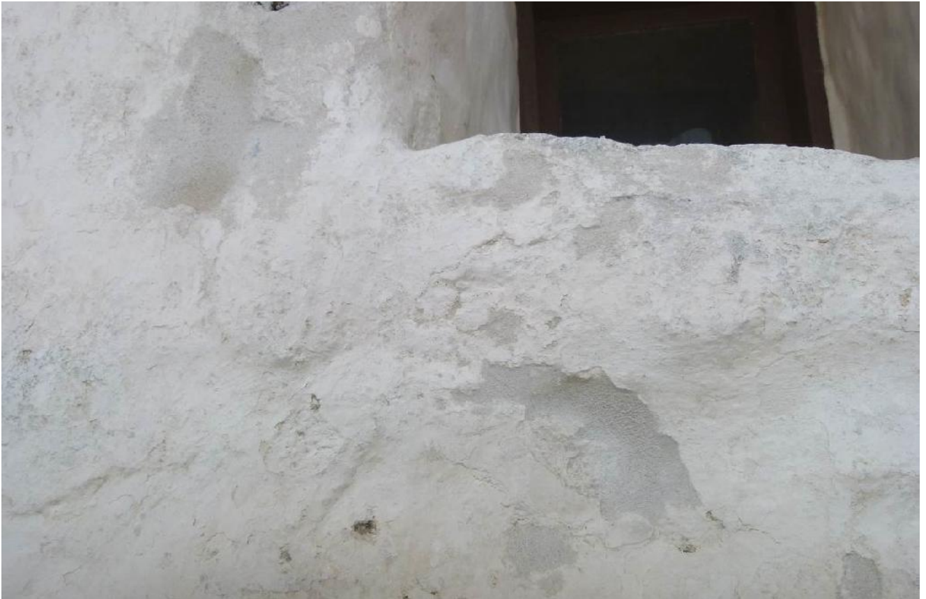
Repareret murværk – sydside med ujævn overflade. De grå flader er kulekalkmørtel.
