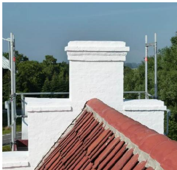
Kamtakkerens ”indersider” fik 2- 3 gang kalk mere – op til 8 gange i alt.
