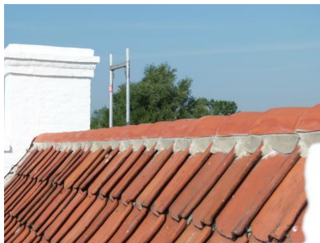
Rygningen blev omlagt med nye rygningsten i en cementmørtel.
