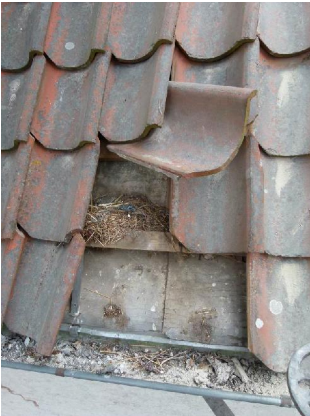
Undertaget mangler fodblik, og asfaltbaneren år ikke helt ned i tagrenden. Der er samlet meget skidt og nogle steder er der fuglereder.
