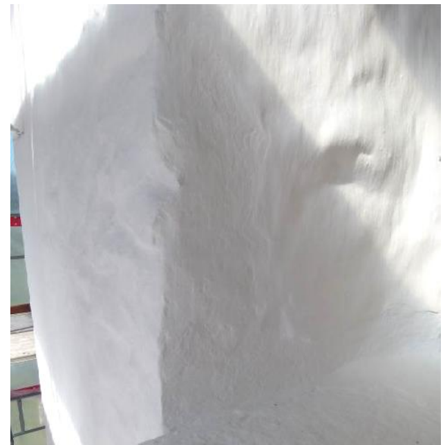
Det samme sted efter behandling med en finkortet sandkalk, der udjævner/slører de skarpere overgange – og 5-6 gange kalk.
