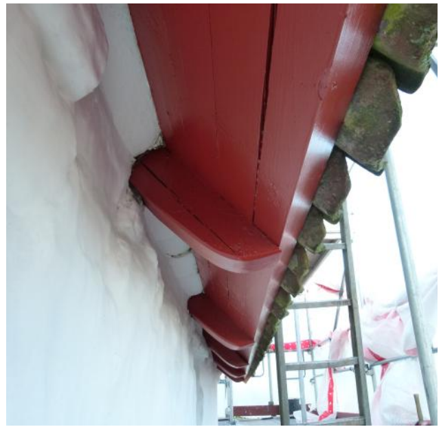
Skalke og underslagsbrædder blev skrabet og malet røde.
