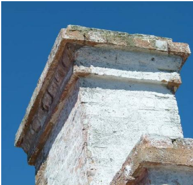
Plastmaling på bar sten – sad fast.
