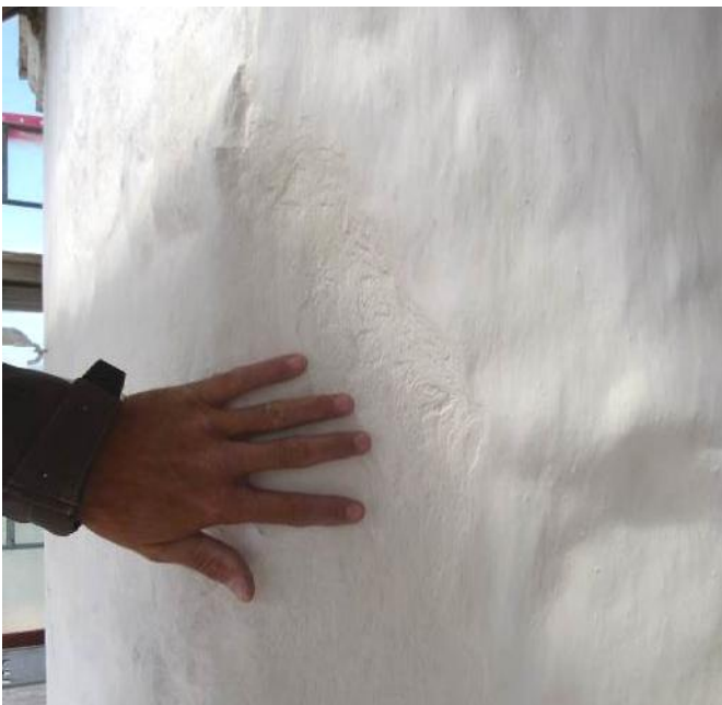
Eksempel på nænsom afrensning med skraber, der udjævner overgangen fra de urørte yderste kalklag, t.h. og til underliggende fastsiddende kalklag.
