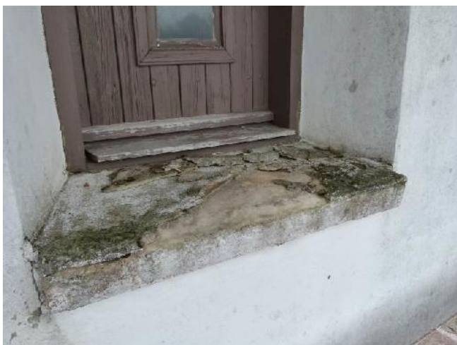
Løst cementreparation på en sandstenssølbænk blev afrenset.
