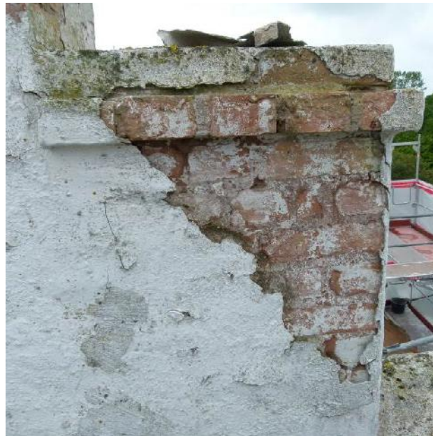
Plastikholdig ”strygepuds”- løsnede nemt.
