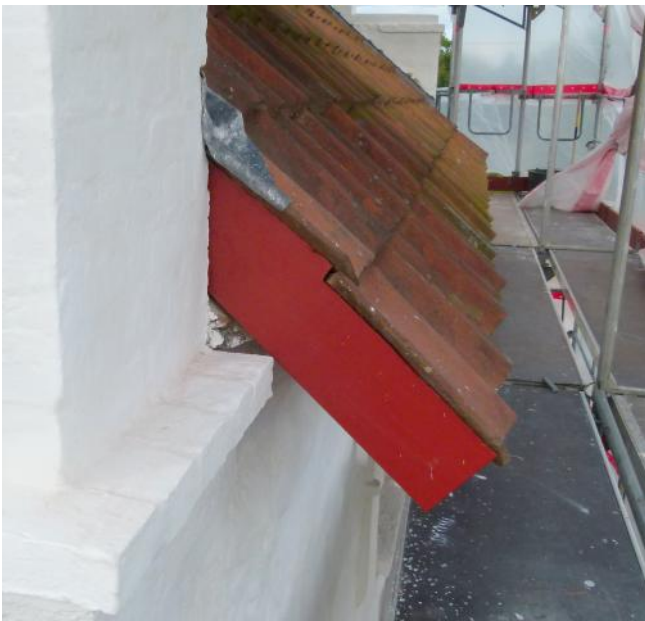
De fire små vindskeder blev udskiftet og malet røde
