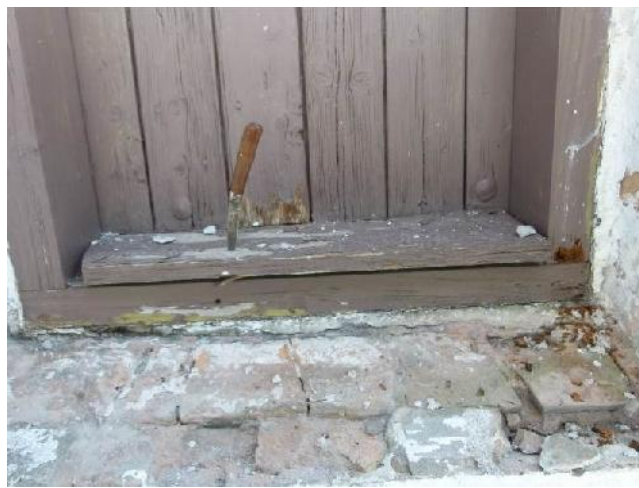
Flere vandbrædder blev udskiftet
