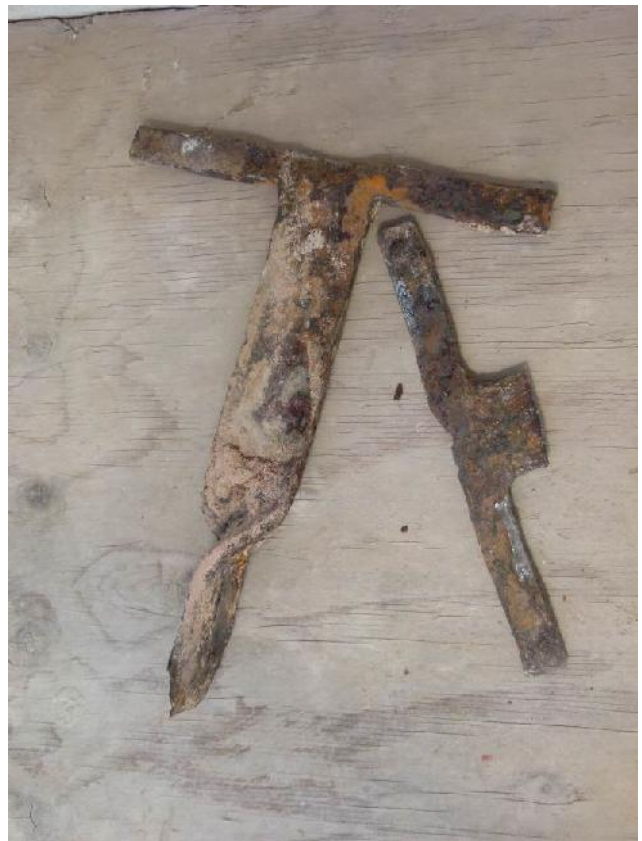
De udtagne ankere. To andre kunne ikke udtages, uden større udhugninger – de blev siddende.
