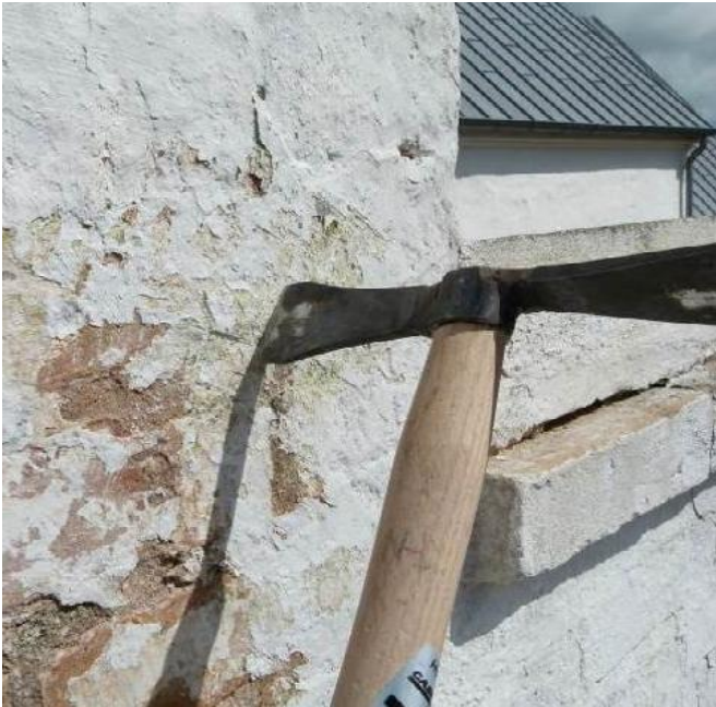
Afdækningshammeren løsner lagene.
