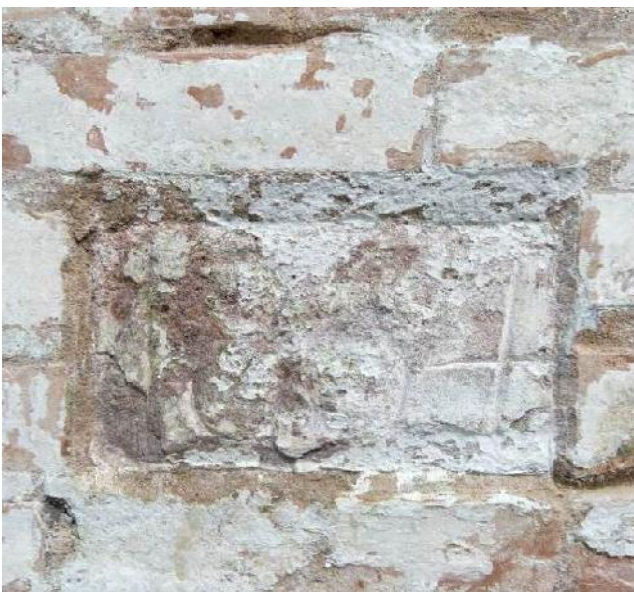
Afrenset – forsigtigt – det er en nexøsandsten, let forvitret, men årstallet 1846 anes.
