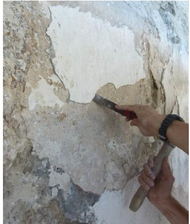
Med forsigtighed ”skrælles” det tynde lag cement af.
